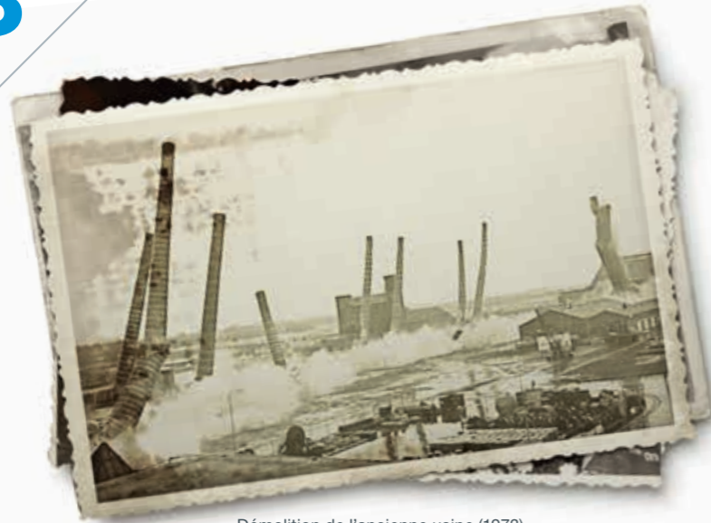
Démolition de l'ancienne usine (1973)
