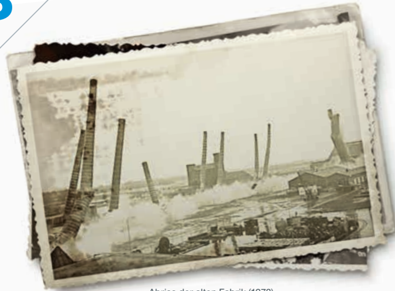
Abriss der alten Fabrik (1973)
